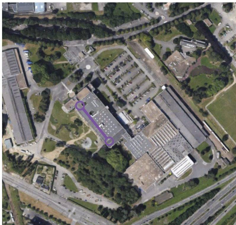
— Lien fibre optique multimode upgradé
